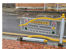
어린이 안전 (안전펜스 파손)
