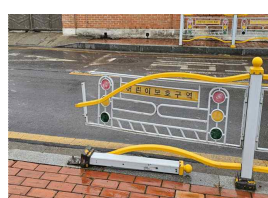
어린이 안전 (안전펜스 파손)
