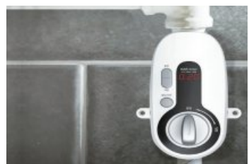
자동 가스누설차단기 설치
