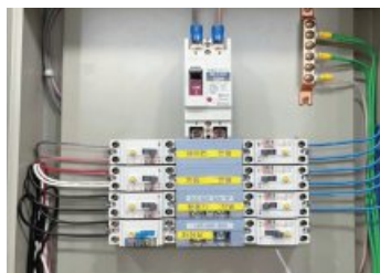
[ ② 전기 배전반에 접지선 연결 ]
